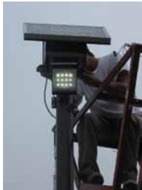
伊達市ソーラー街路灯設置
