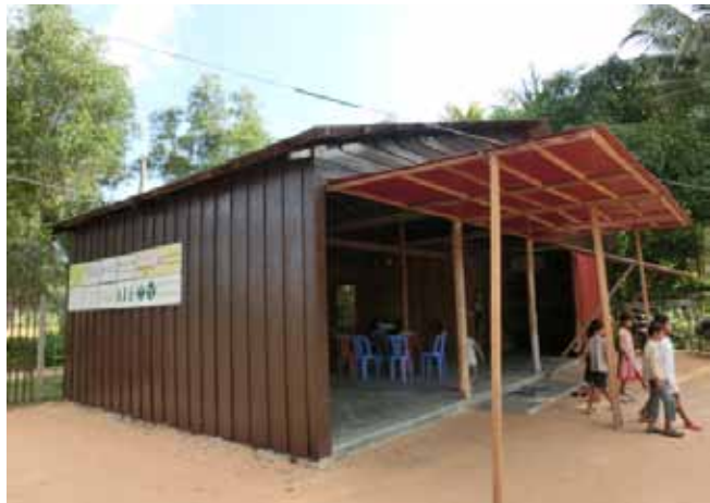
改修後の納屋
