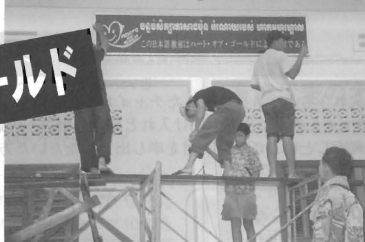
看板を取り付け作業
