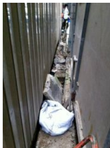
第一現場の個人宅 隣の工場との境の溝の瓦礫を取り除き、溜まったヘドロをかき出す
